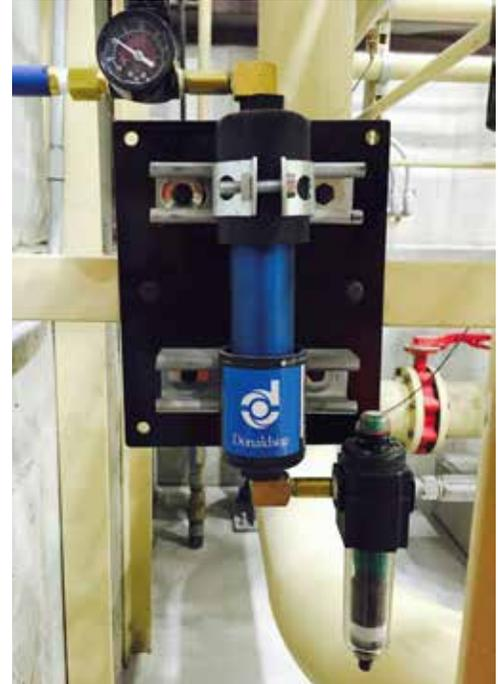
*\*No se recomienda el uso del Secador de aire de depósito en tanques que almacenen gasolina o para el espacio libre de cualquier líquido inflamable (punto de ignición a 100 °F/38 °C).*
